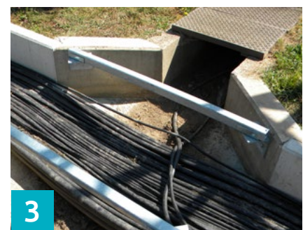
Einpassung des Vierkantrohr (50 × 50 mm) in die Winkelkonsole.
