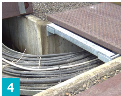
Einpassung des Vierkantrohrs (50 × 50 mm) in die Winkelkonsolen.
