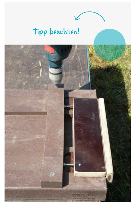
Montage der Verrutschschutzleisten mit den beiliegenden Edelstahlschrauben. Unser Tipp: Mit Hilfe einer verstellbaren Lehre montieren Sie schnell und passgenau!
