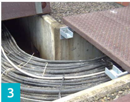
Befestigung der zwei 90° Winkelschuhe mit zwei M10 Bolzenankern je Winkelkonsole.
