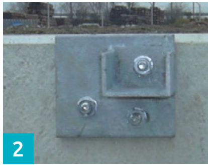
Verwendung von vorgefertigten 90° Winkelkonsolen.
